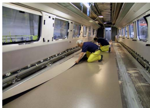
2. Posa a secco dei teli con sormonta
