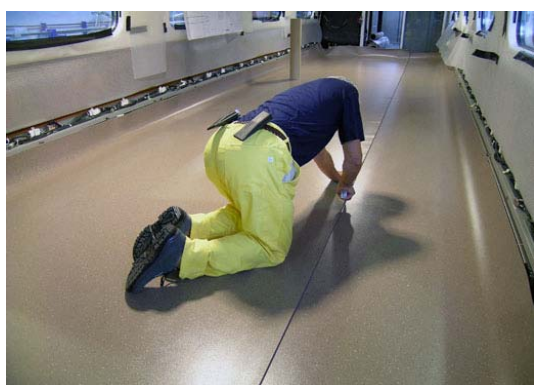
3. Rifilare la sormonta
